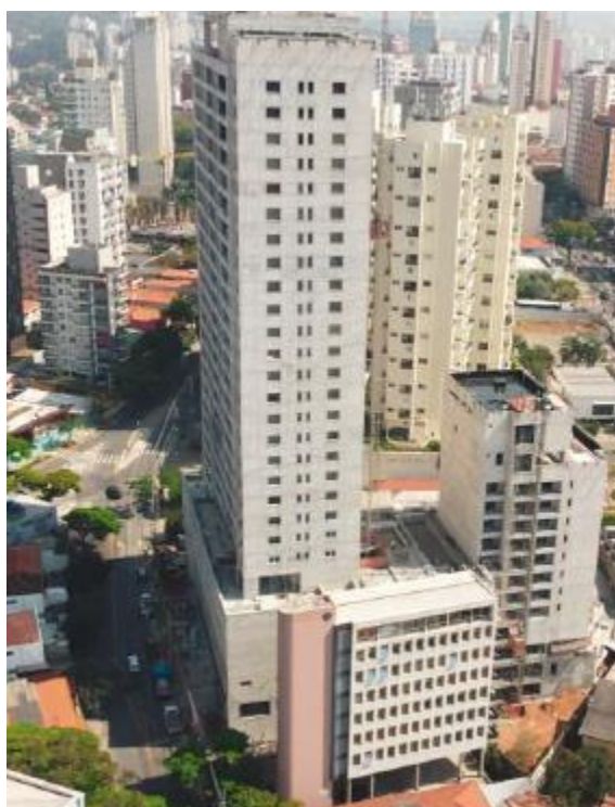
Foto Fachada da Obra - Misce
