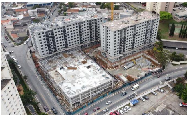
Foto Estrutura Obra
