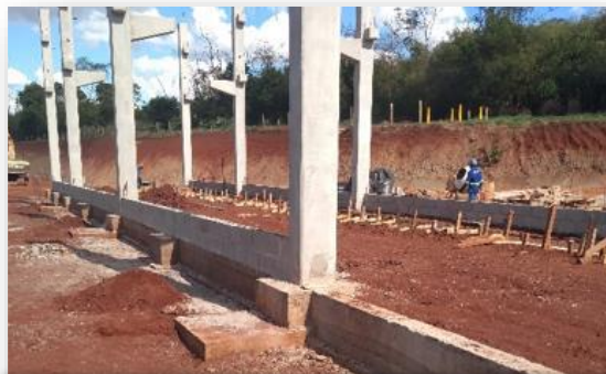
Tulha ferroviária (início da superestrutura)
