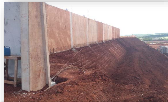
Armazém de açúcar (início da pavimentação)
