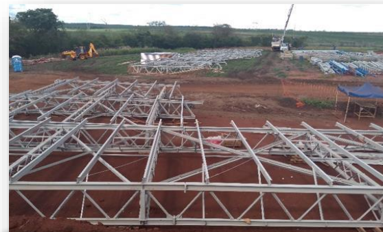
Pré-montagem das estruturas metálicas
