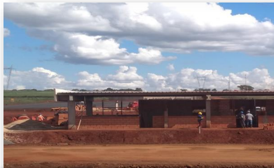
Escritório administrativo, laboratório e vestiário
