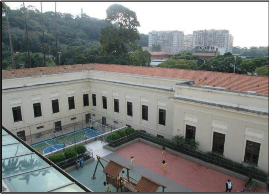
Vista do Pátio Interno
