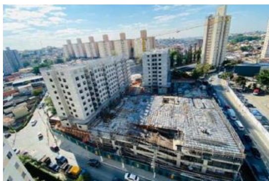
Foto Estrutura Obra
