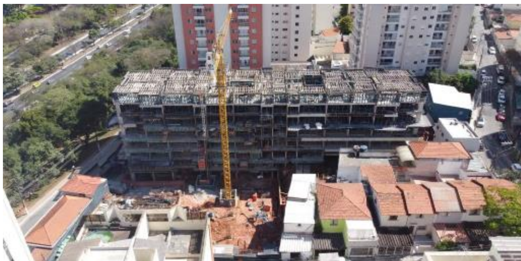
Foto Vista Geral Obra
