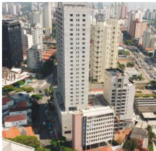
Foto Estrutura da Obra - Misce
