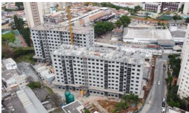
Foto Estrutura Obra
