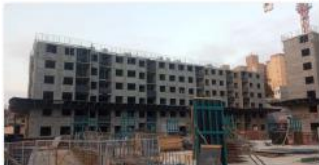
Foto Estrutura Obra
