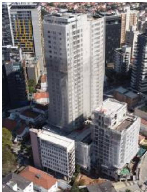
Foto Estrutura da Obra - Misce
