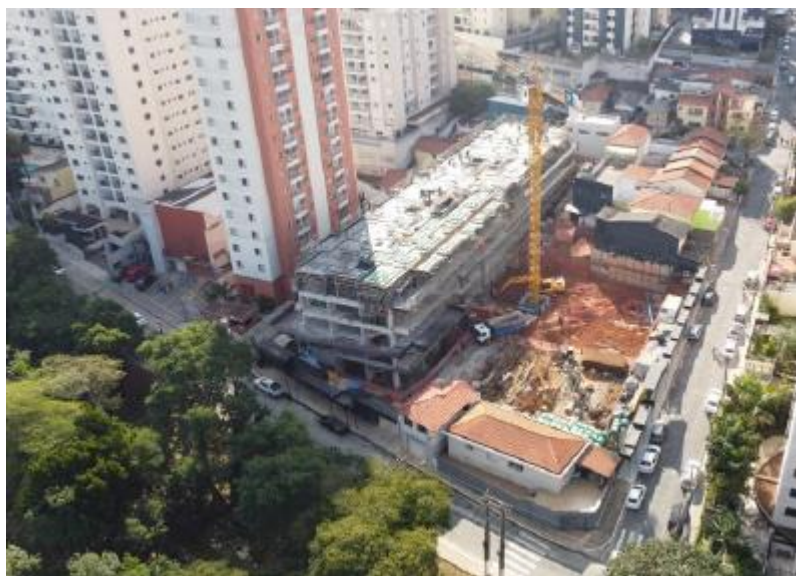
Foto Vista Geral Obra
