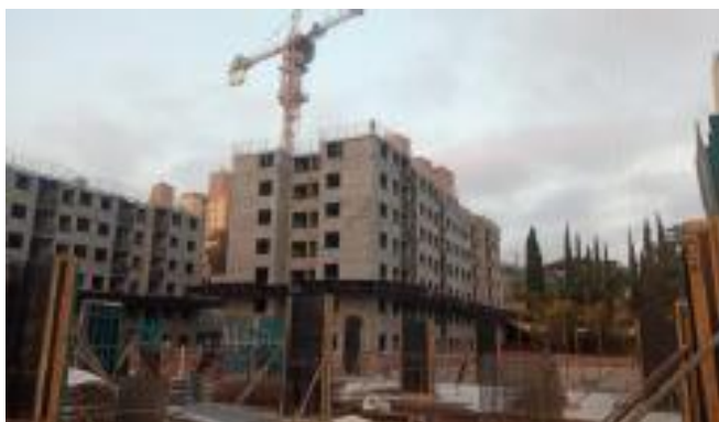
Foto Estrutura Obra
