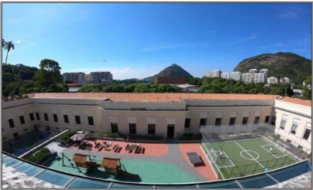
Vista do Pátio Interno
