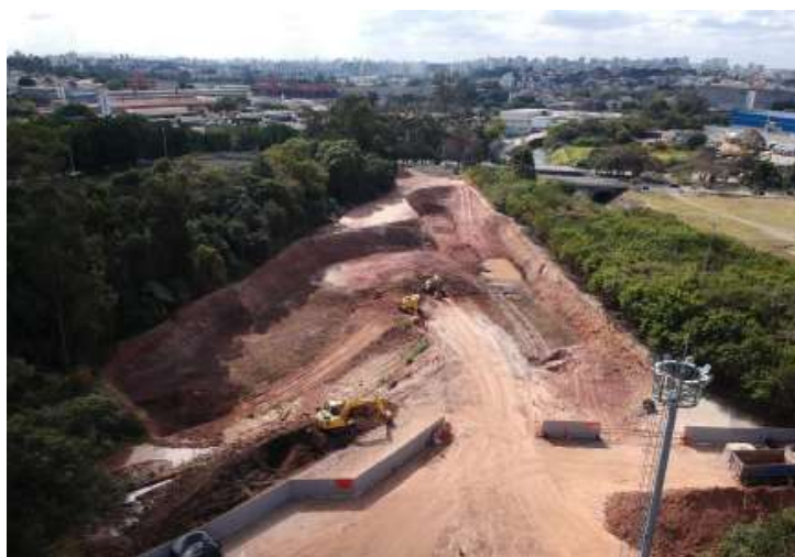
Remediação Ambiental: Escavações do Pátio Vietnã Futuros Prédios 900 e 1000 – 07/07/2021
