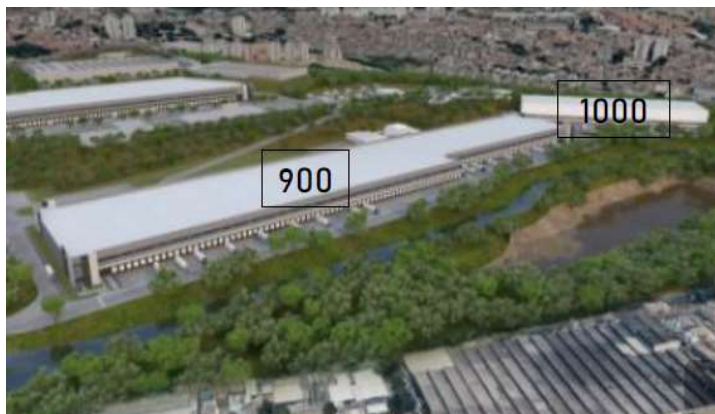
Atual Prédio 16 e Pátio, futuros prédios 900 e 1000 – 07/07/2021
