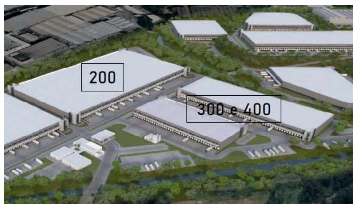
Atual Prédio 90, futuros prédios 300 e 400 - 07/07/2021
