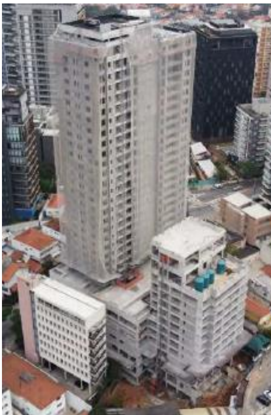
Foto Estrutura da Obra - Misce
