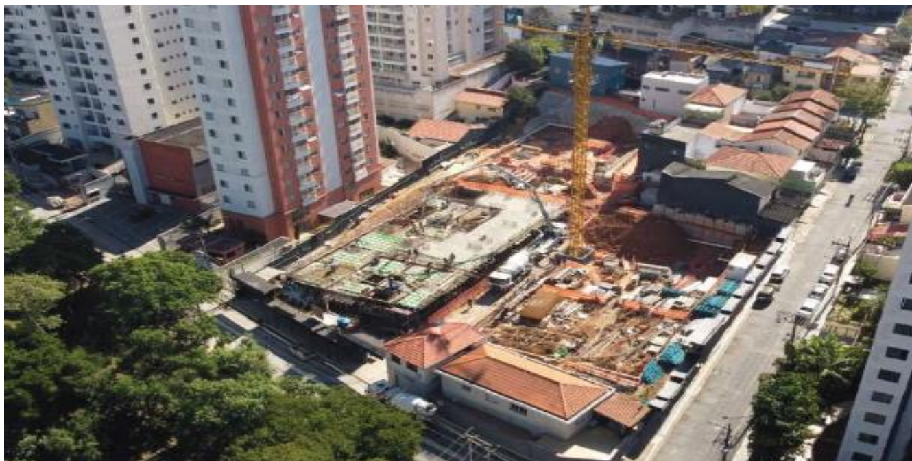
Foto Vista Geral Obra e início da Fundação
