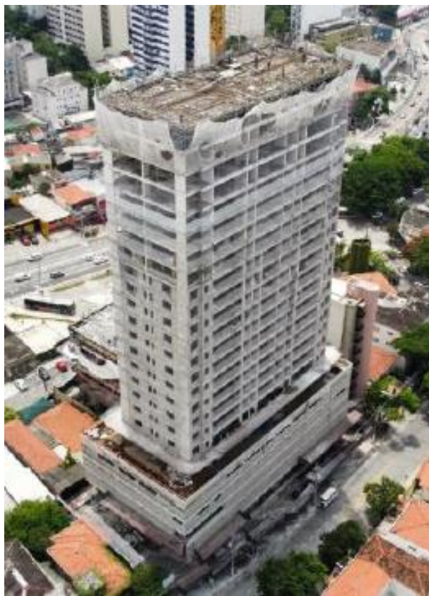
Foto Estrutura da Obra - Misce
