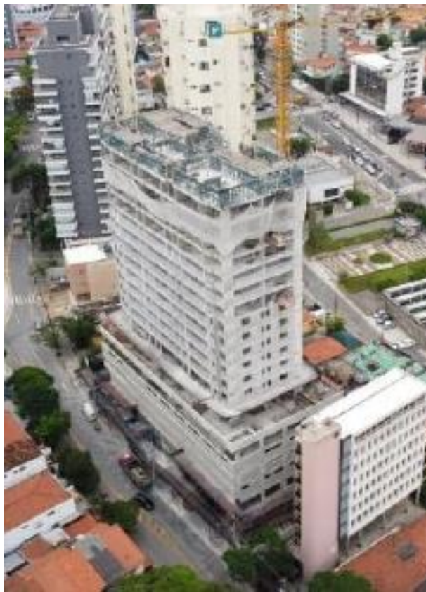
Foto Estrutura da Obra - Misce
