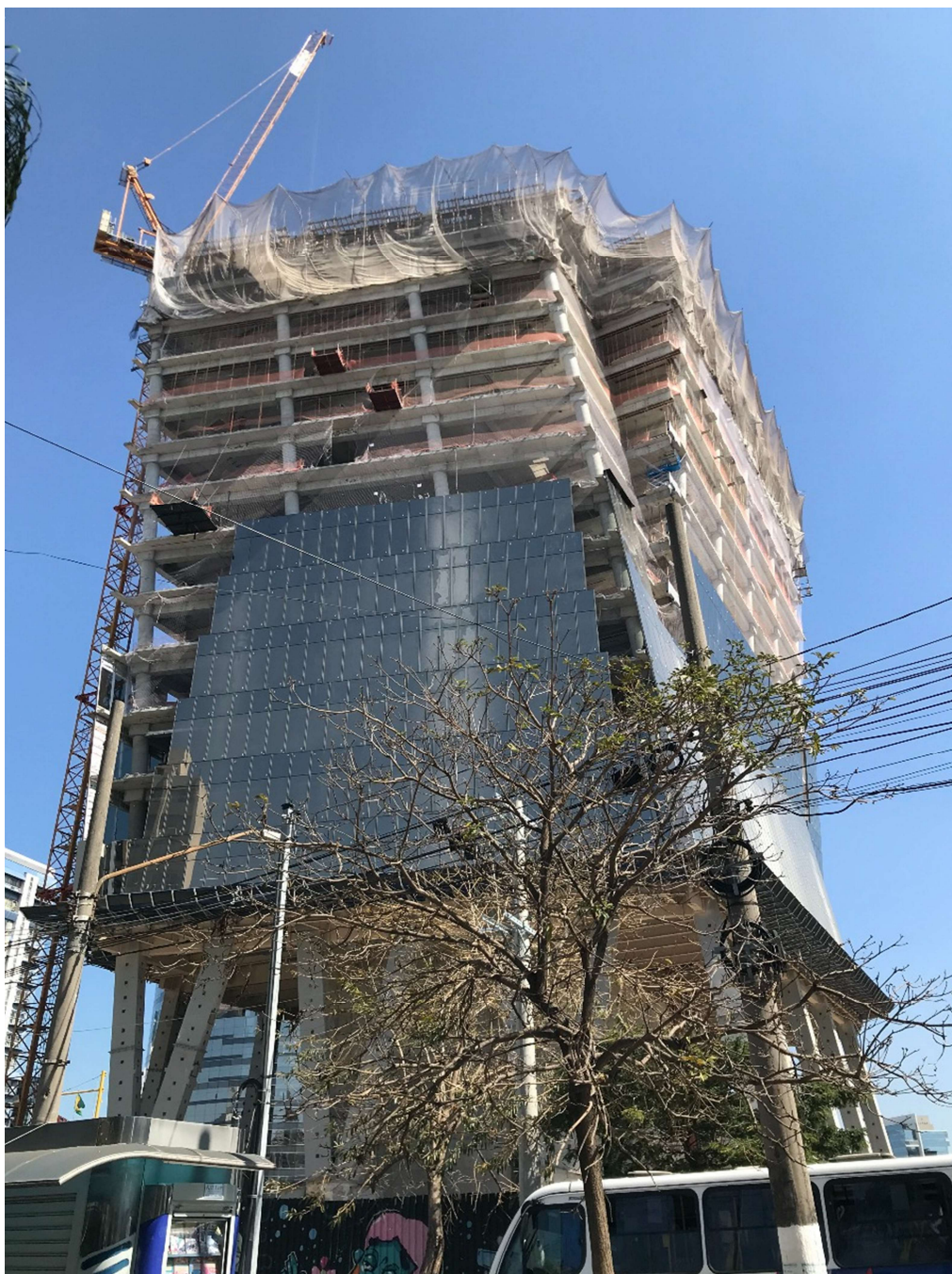
Foto da obra em andamento
