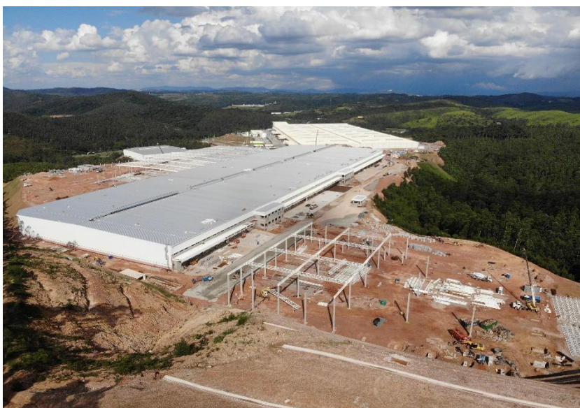
Execução de obras – Foto Panorâmica
