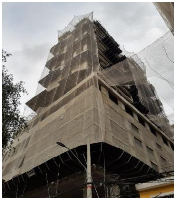
Foto Estrutura da Obra - Facto
