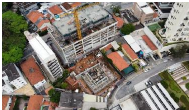
Foto Estrutura da Obra - Misce
