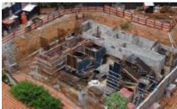
Foto Estrutura da Obra Torre Studios - Misce
