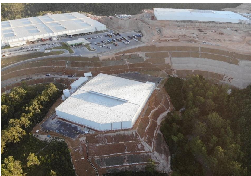
Execução de obras – Foto Panorâmica
