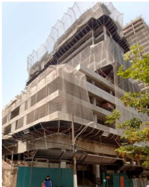
Foto Estrutura da Obra
