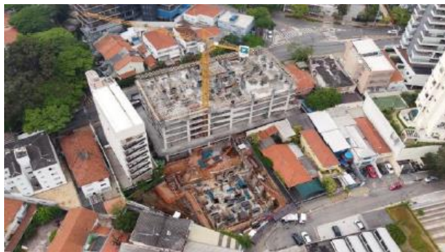
Foto Estrutura da Obra
