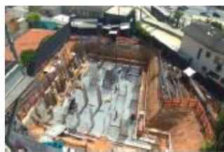
Foto Estrutura da Obra
