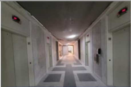
Obras em andamento no 33º pavimento
