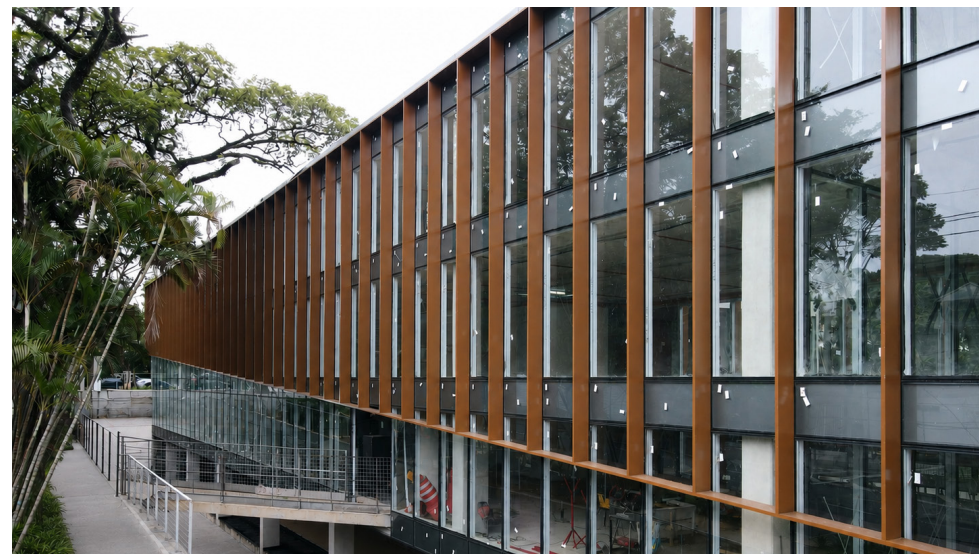
FOTO DA OBRA
