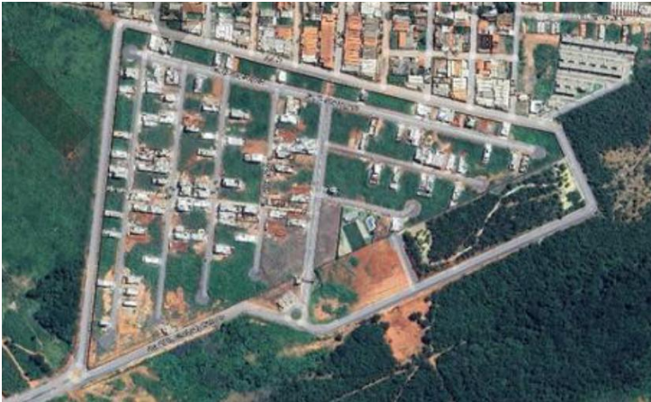
Foto aérea do empreendimento
