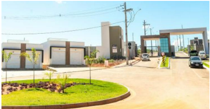
Entrada do empreendimento
