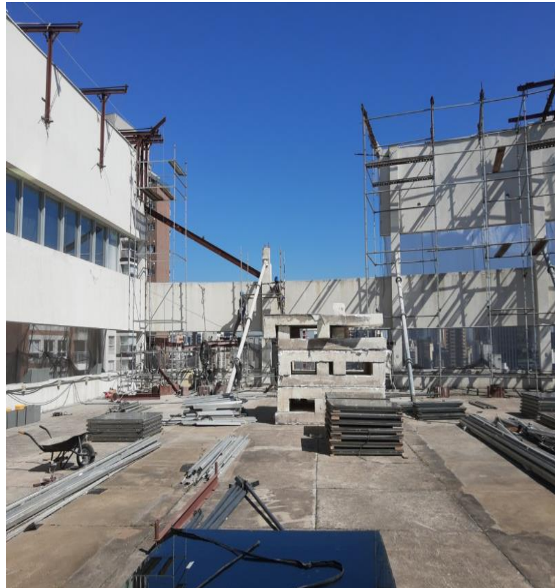
Restituição da Viga da Cobertura
