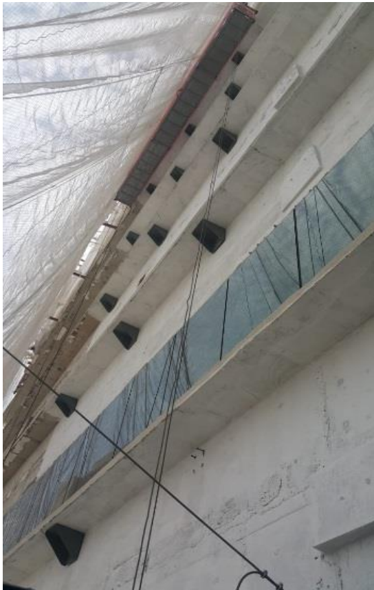
Tratamento e impermeabilização da estrutura da fachada
