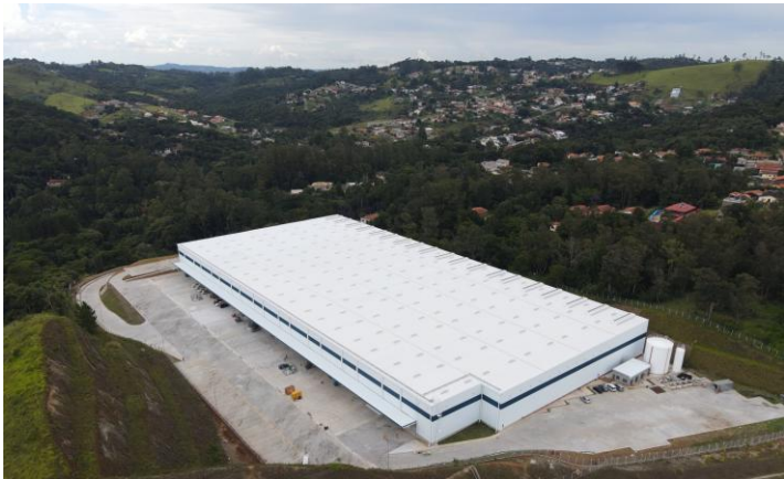
Imagem 2: Foto aérea do galpão
