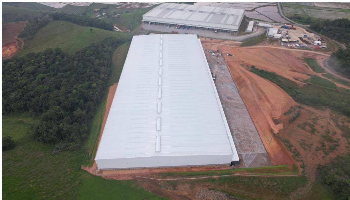
Construção Nave 2 – Foto Panorâmica
