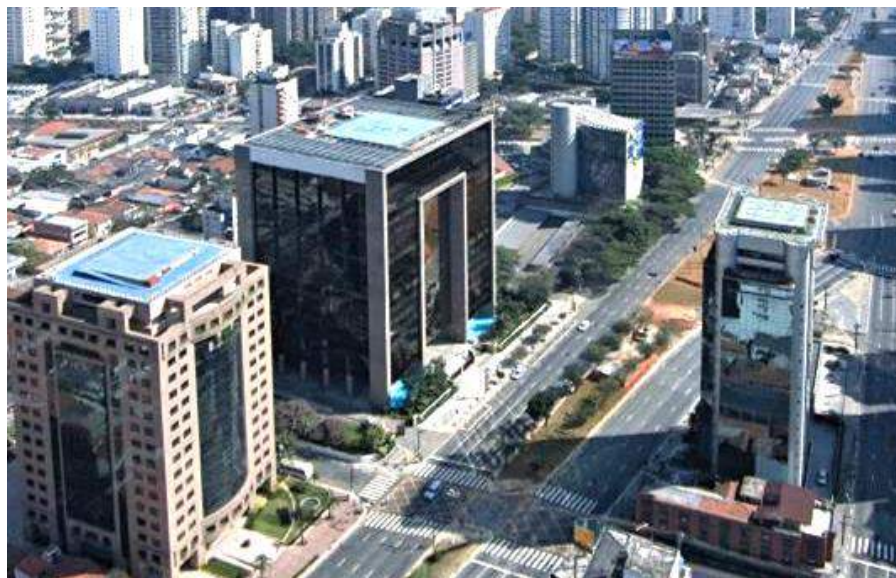
Figura 4 – Avenida Brigadeiro Faria Lima, São Paulo/SP – CBRE.
