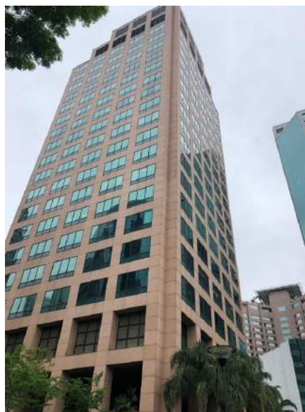
VISTA DA FACHADA DO EDIFÍCIO
