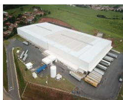
CD Panasonic Itapeva, MG Estrada do Mandu, 250 Área construída: 23.454 m 2 Participação: 100% Pé-direito (m): 12 Capacidade do Piso (ton/m 2 ): 6
