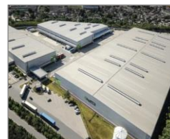
Syslog RJ Duque de Caxias, RJ Avenida OL-1 Área construída: 57.034 m 2 Participação: 100% Pé-direito (m): 11 Capacidade do Piso (ton/m 2 ): 3-5
