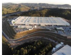
CD Leroy Cajamar, SP Rod. dos Bandeirantes, km 34 Área construída: 110.209 m 2 Participação: 100% Pé-direito (m): 11 Capacidade do Piso (ton/m 2 ): 6
