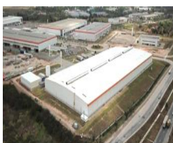
CD Unilever (MM1) Cabo de Santo Agostinho, PE ROD BR101, Sul Km 96,4, 5.225 Área construída: 23.025 m 2 * Participação: *90% Pé-direito (m): 12 Capacidade do Piso (ton/m 2 ): 5
