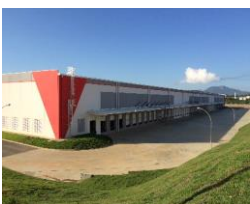
CD Renner São José, SC Av. Osvaldo José do Amaral, s/n Área construída: 47.913 m 2 Participação: 100% Pé-direito (m): 12 Capacidade do Piso (ton/m 2 ): 6
