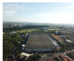
CD Dia Americana Americana, SP Rua João de Pádua, 245 Área construída: 30.345 m 2 Participação: 100% Pé-direito (m): 10 Capacidade do Piso (ton/m 2 ): 4
