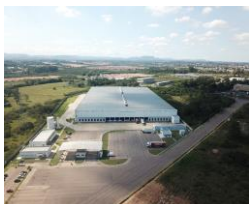
CD Via Varejo Cachoeirinha, RS Rua Lenine Queiróz, 333 Área construída: 38.410 m 2 Participação: 100% Pé-direito (m): 12 Capacidade do Piso (ton/m 2 ): 5
