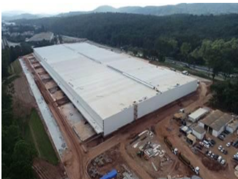
Execução de obras – Foto Panorâmica
