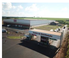
CD Dia Ribeirão Ribeirão Preto, SP Via José Luiz Galvão, 1.905 Área construída: 21.136 m 2 Participação: 100% Pé-direito (m): 12 Capacidade do Piso (ton/m 2 ): 6
