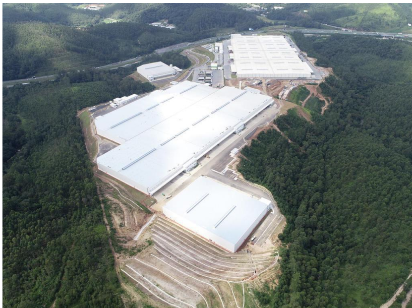
Execução de obras – Foto Panorâmica
