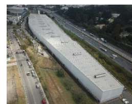
WTTP II Barueri, SP Av. Ceci, 1.649 Área construída: 24.654 m 2 * Participação: *80% Pé-direito (m): 11 Capacidade do Piso (ton/m 2 ): 3-5
